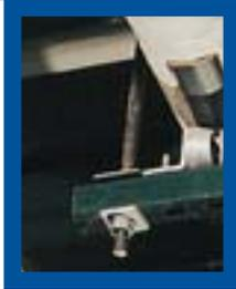
*Los rodillos se instalan en los rieles acanalados para permitir el movimiento de expansión térmica de las tuberías.*
