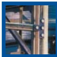
*Las piezas de montaje de alta resistencia proveen conexiones a prueba de deslizamiento para las escaleras, los peldaños y sus soportes laterales.*
