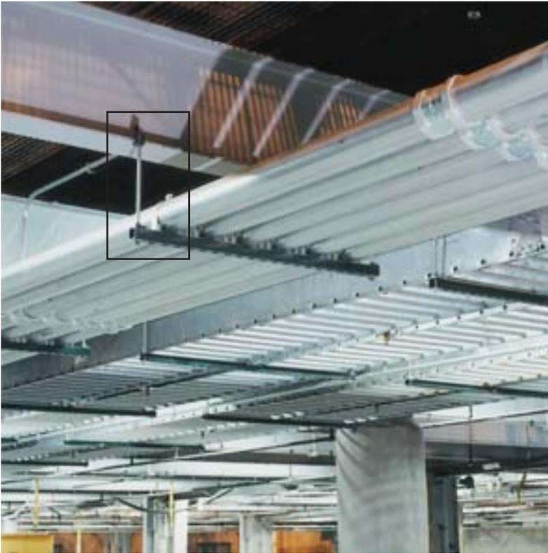
*Esta abrazadera para vigas utiliza varillas roscadas.*
